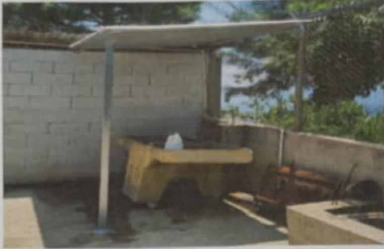
**Modulo 4:** Sustitución de pila de cemento de dos lavaderos, sustitución de llave de globo, llave de chorro e instalación de estructura portante de metal.
