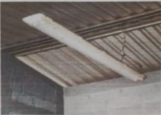
Modulo 2: Reparación del cableado eléctrico, sustitución de ducto eléctrico más accesorios.
