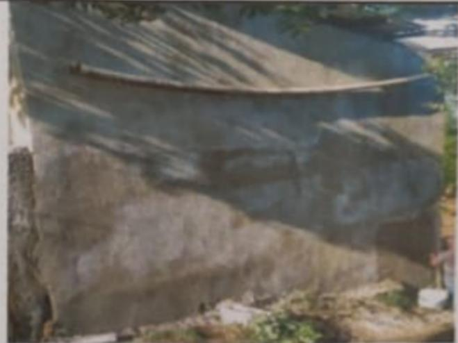
**Modulo 5:** Aplicación de repello en muro de contención.
