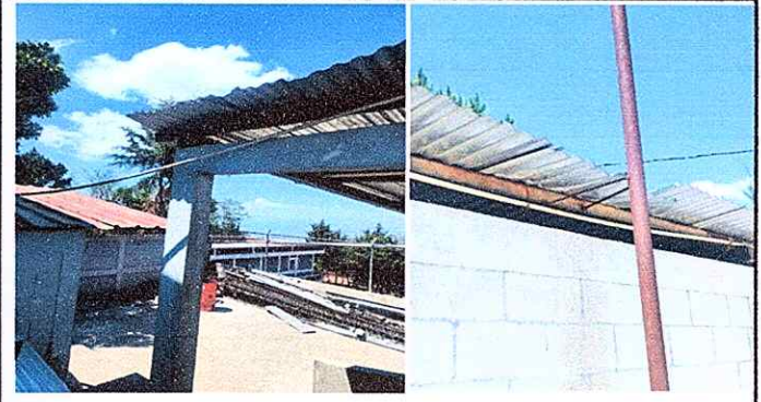
Modulo: Sustitución de tubería lineal principal de abastecimiento de agua potable.
