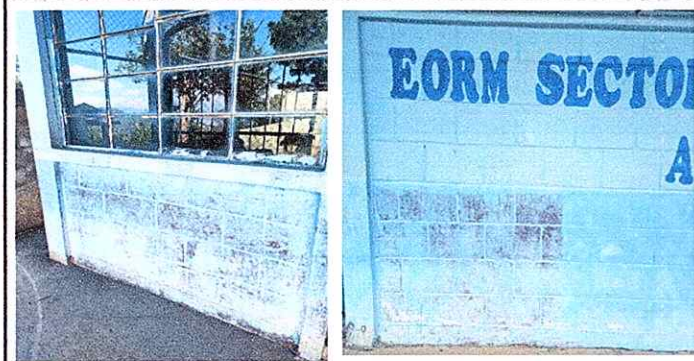
Modulo 1: Pintura en paredes interiores y exteriores de todo el establecimiento.
