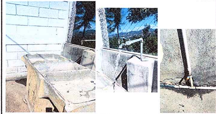
Modulo 4: Sustitución de pila de cemento de dos lavaderos, sustitución de llave de globo, llave de chorro e instalación de estructura portante de metal.
