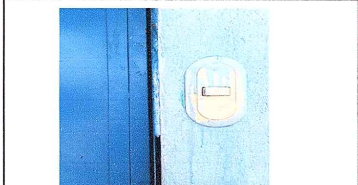
Modulo 2: Sustitución de interruptores dobles
