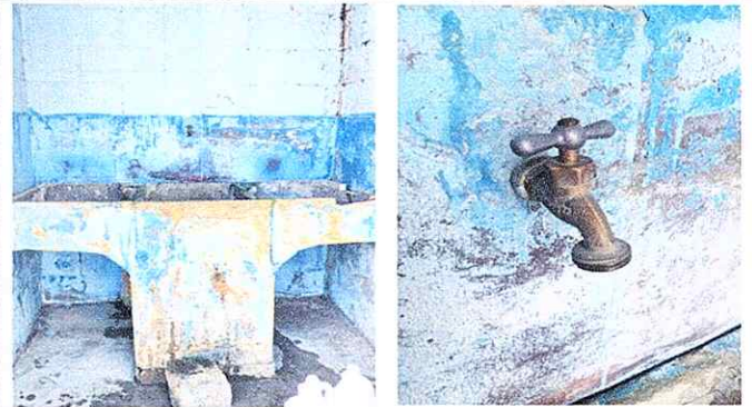
Modulo 3: Sustitución de pila de cemento de dos lavaderos por una formal y sustitución de grifo.
