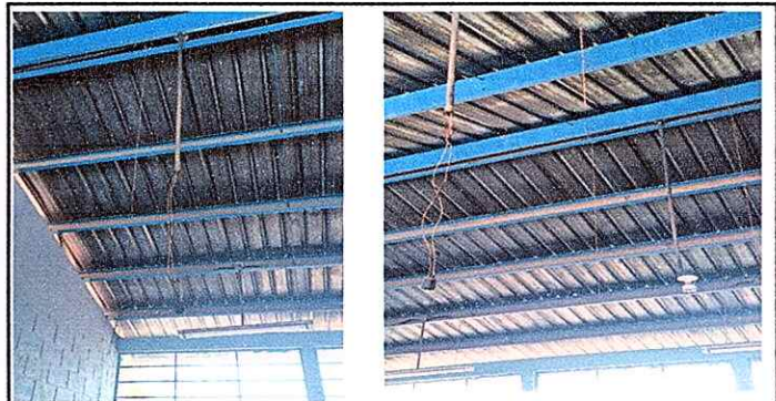
Modulo 2: Sustitución de plafoneras y sustitución de focos ahorradores.
