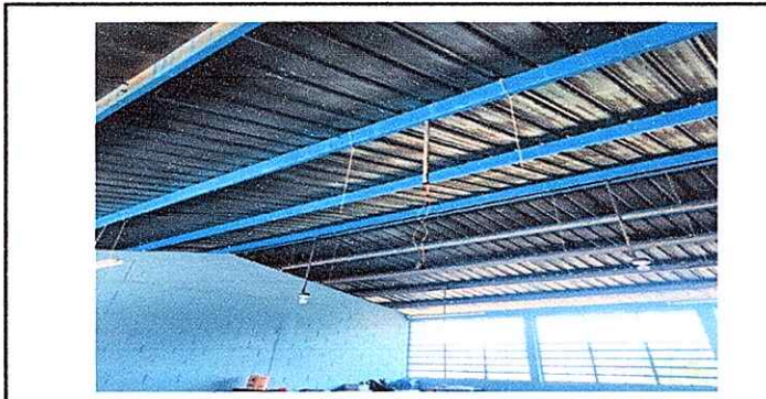
Modulo 2: Reparación del cableado eléctrico, sustitución de ducto eléctrico más accesorios.
