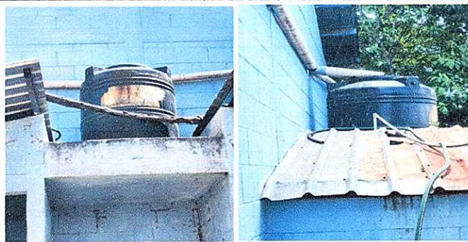
Modulo 3: Sustitución de deposito de agua 1700 lt.
