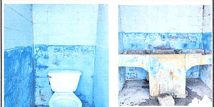
Modulo 3: Pintura en muros interiores y exteriores.
