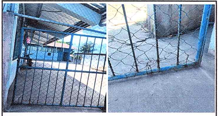
Modulo 5: Sustitución portón de metal.
