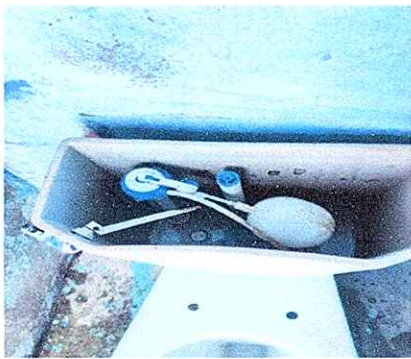
Modulo 3: Sustitución de accesorios de inodoro
