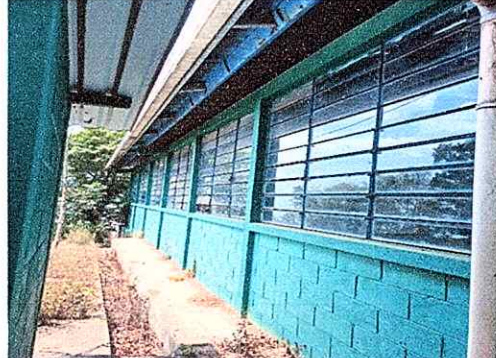
Modulo 2: Fabricación e instalación de balcones en ventana
