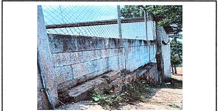
Modulo 5: Aplicación de repello en muro decontención.
