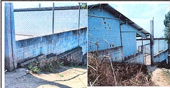
Modulo 5: Pintura en muros exteriores e interiores.
