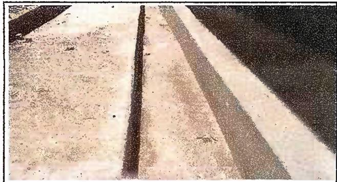
Foto 4: Reparación de cuneta de concreto
