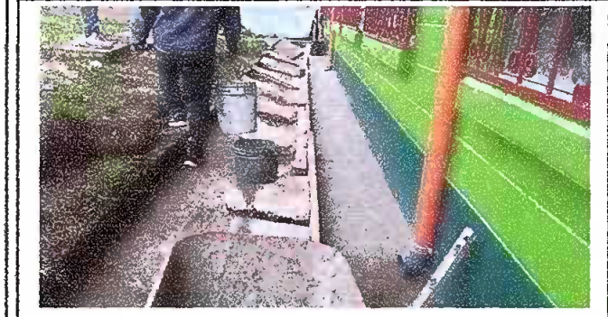
Foto 3: Reparación de banquetas de concreto
