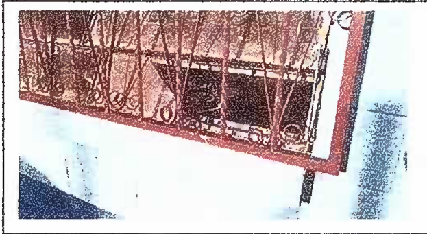
Foto 1: MODULO 2, Mantenimiento a balcones de metal
