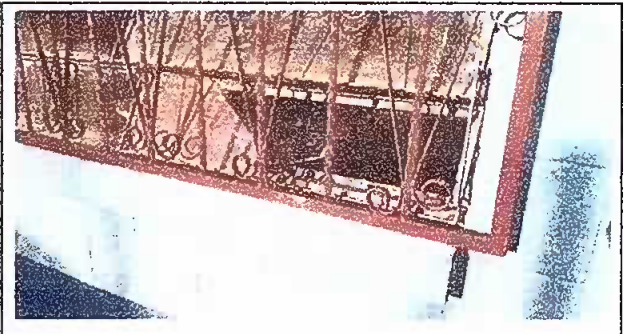
Foto 4: Mantenimiento a balcones de metal
