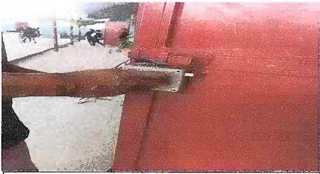
Foto 5: MODULO 2. sustitución de chapa
