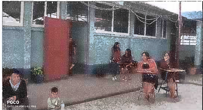
Foto 4: MODULO NO. 2 sustitución de ventana de metal por PVC más vidrio.
