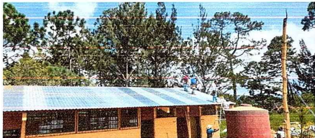
Foto 1: MODULO 1: Sustitución de lámina, por lámina troquelada aluzinc calibre 26.
