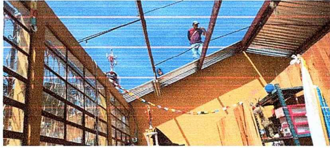
Foto1: MODULO 1:Sustitución de lámina, por lámina troquelada aluzinc calibre 26.
