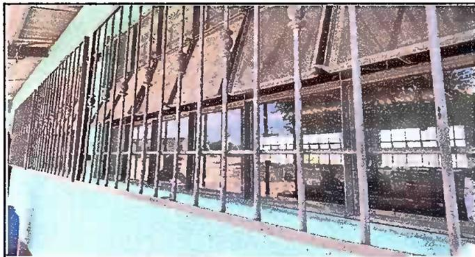
Foto 5: Balcones colocados en las ventanas del establecimiento, para su protección.
