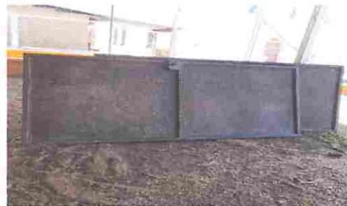
Foto 5: Modulo 4,5 mantenimiento de estructura de puertas lijado y pintura
