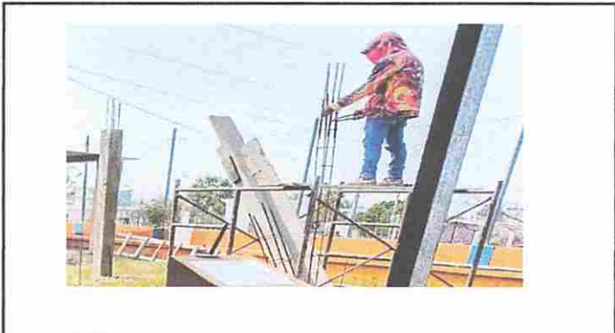
Foto 3: Modulo 1 Techado de la pila
