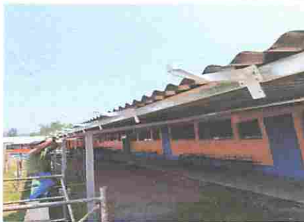
Foto Modulo 1 Sstitución de canal de pvc, sstitucion de soporte o pescante de metal para canal .
