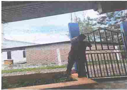
Foto 3: Modulo 1 Sustitutción de Portón de Metal
