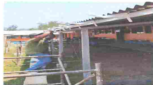
Foto Modulo 1 sstitucion de soporte o pescante de metal para canal .
