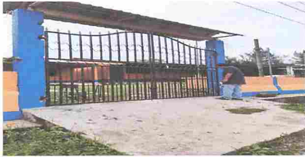
Foto1: Modulo 1 Sustitucion de Porton de Metal.
