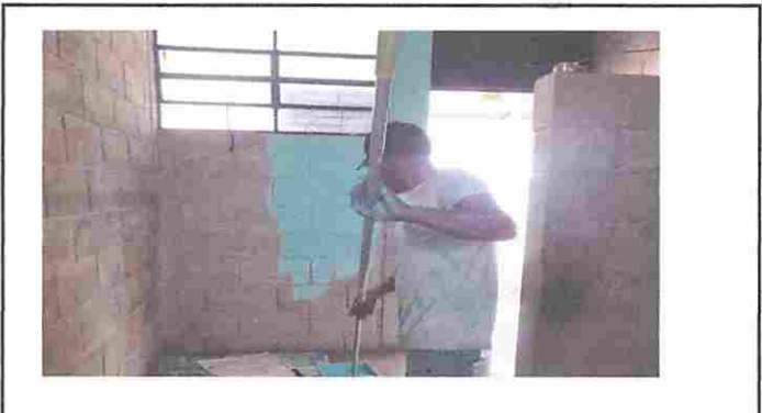
Foto 4: Modulo 1 Mantenimiento de estructura a puertas servicios sanitarios
