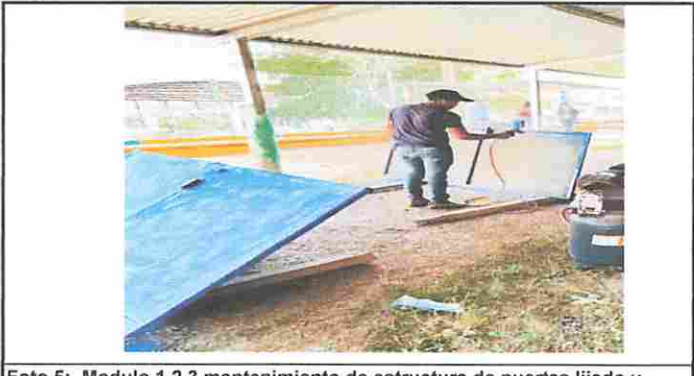
Foto 5: Modulo 1,2,3 mantenimiento de estructura de puertas lijado y pintura
