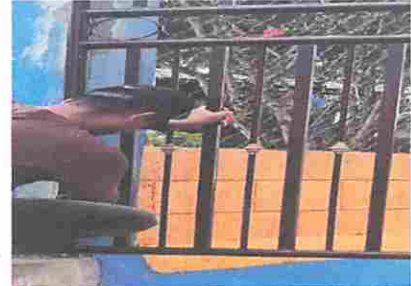
Foto 2: Modulo 1 Sustitucion de Porton de Metal.
