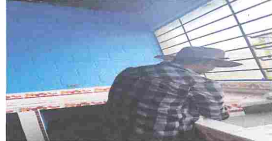
Foto 2: Modulo 5 reparacion de azulejo en muebles de cocina
