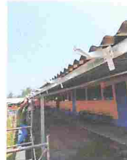
Foto Modulo 1 Sstitución de canal de pvc, sstitucion de soporte o pescante de metal para canal .
