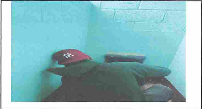
Foto 2: Modulo 1 sustitucion 4 Inodoros
