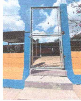
Foto 2: Modulo 1 Sustitucion de Porton de Metal.
