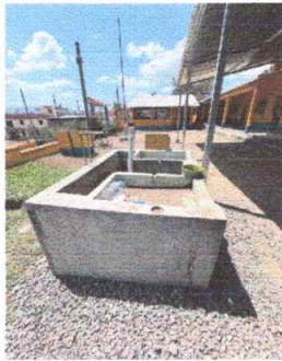
Foto 3: Modulo 1 Instalacion de pila, Instalacion de Azulejo.
