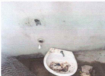
Foto 3: Modulo 1 sustitucion de lavamanos
