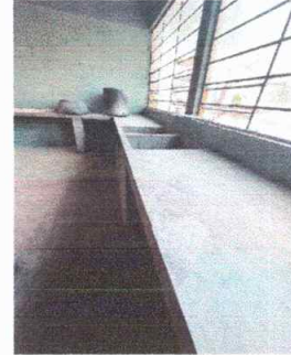
Foto 2: Modulo 5 reparacion de azulejo en muebles de cocina
