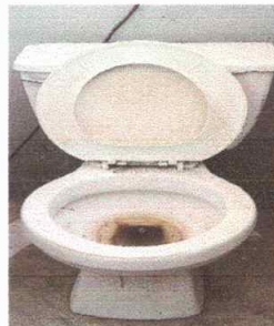
Foto 2: Modulo 1 sustitucion 4 Inodoros
