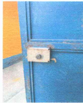
Foto 6: Modulo 4 Sustitución de Chapa
