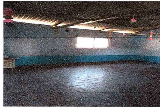
FOTO 4: MODULO 1: Pintura de muros interiores y exteriores.
