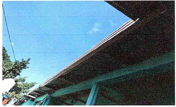
FOTO 2 :MODULO 1: Sustitución de canal PVC.
