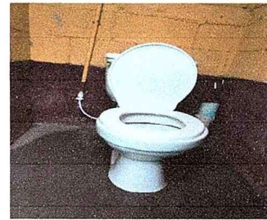
FOTO 6: MODULO 2: sustitución de inodoros.
