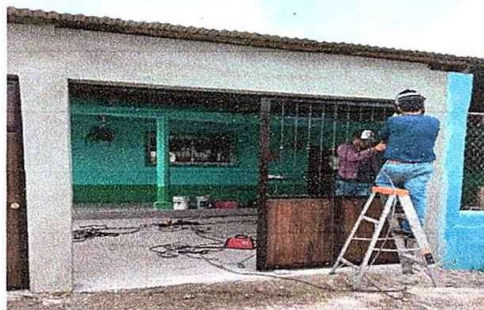
FOTO 11: MURO PERIMETRAL: Sustitución de porton de metal.
