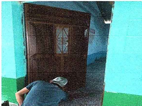
FOTO 5: MODULO 1: Mantenimiento a estructura de puerta (reparación de puerta).
