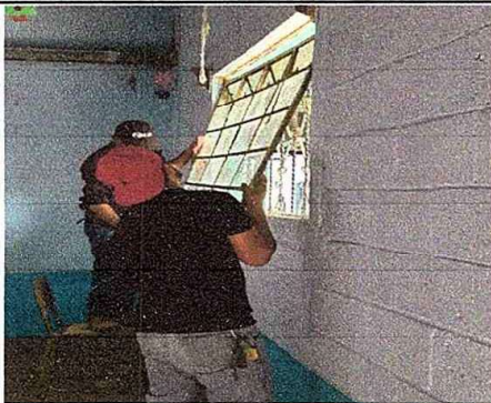
FOTO 3: MODULO 1: Sustitución de estructura de metal de ventanas.
