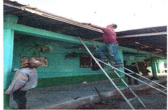
FOTO 2 :MODULO 1: Sustitución de canal PVC.
