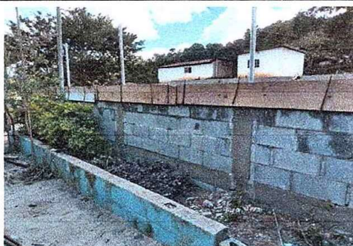
FOTO 9: MURO PRIMETRAL: Reparación de muro perimetral de block con tubo hg, malla galvanizada soleras intermedias y columnas.
