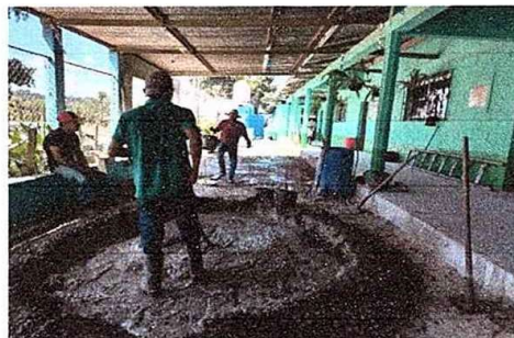
FOTO 8: PATIO: Reparación de plancha de concreto de patio.
