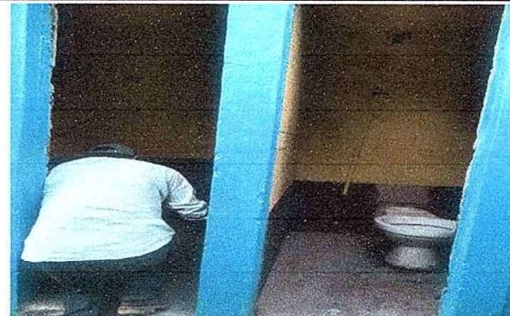
FOTO 6: MODULO 2: sustitución de inodoros.
