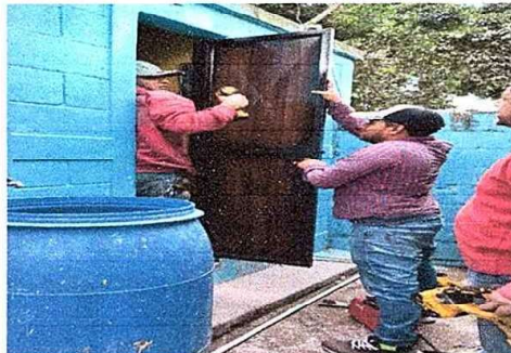
FOTO 7: MODULO 2: Sustitución de puerta en servicios sanitarios.
