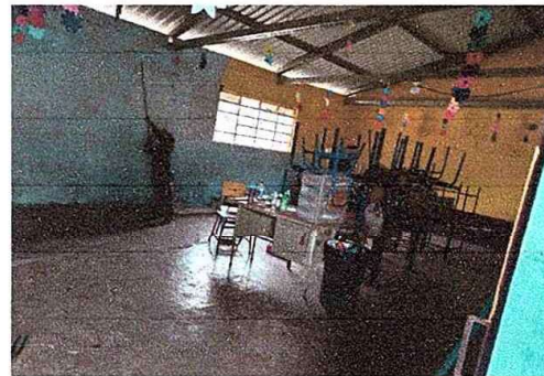
FOTO 4: MODULO 1: Pintura de muros interiores y exteriores.
