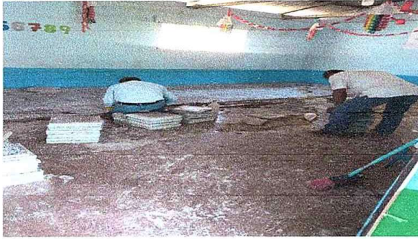
FOTO 1: MODULO 1: Sustitución de piso de torta de concreto por piso de granito.
