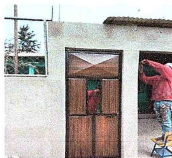
FOTO 10: MURO PERIMETRAL: sustitución de puerta de metal.
