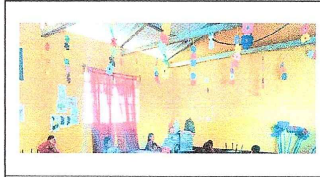
FOTO 4: MODULO 1: Pintura de muros interiores y exteriores.
