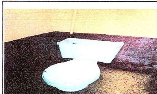
FOTO 6: MODULO 2: sustitucion de inodoros.
