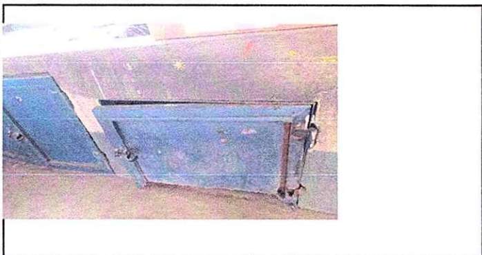
Foto 5: Sustitución de puertas de metal
