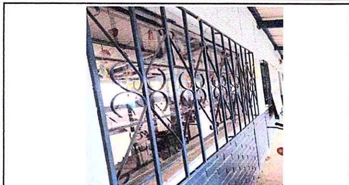
Foto 2: Mantenimientos de balcones
