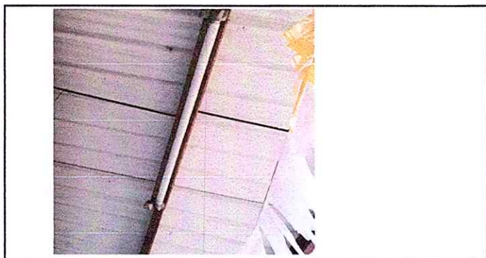
Foto 6: Sustitución de lamparas
