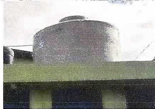
Foto 10: MÓDULO 3: Depósito de agua 2,500 L. instalado.
