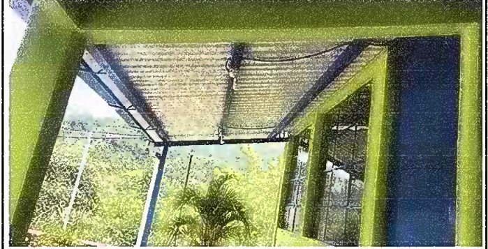
Foto 2: MÓDULO 1: Instalación de estructura de metal y techado finalizado
