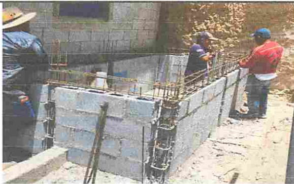
Foto 11: MÓDULO 4: Construcción de pila
