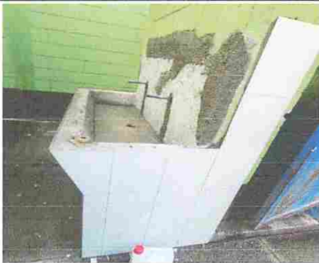
Foto 9: MÓDULO 3: Instalación de azulejos en lavamanos
