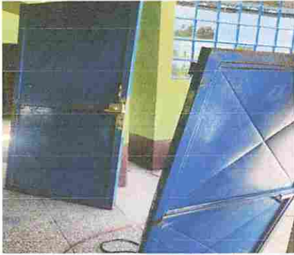
Foto 13: Mantenimiento de puerta de metal y cambio de chapa
