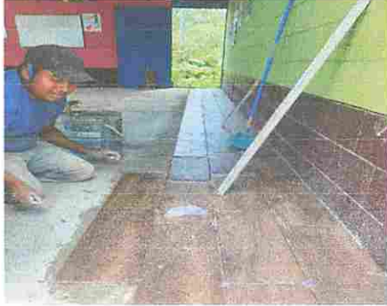
Foto1: MÓDULO 1: Instalación de piso cerámico
