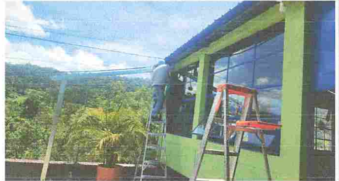
Foto 2: MÓDULO 1: Instalación de estructura de metal y techado
