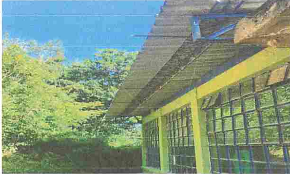
Foto 7: MÓDULO 2: Instalación de canal de metal
