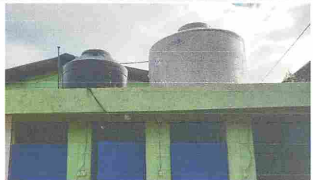
Foto 10: MÓDULO 3: Instalación de depósito de agua 2,500 L.
