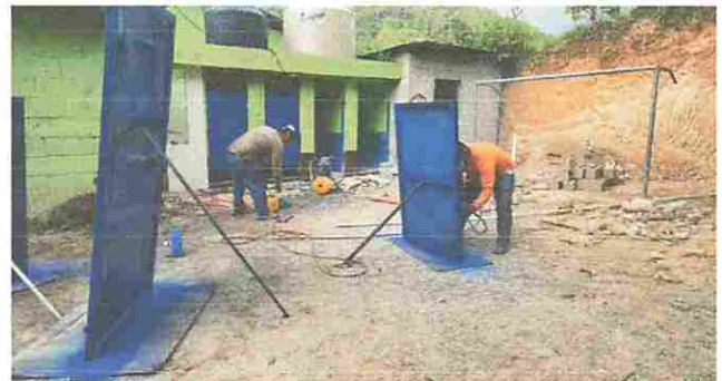
Foto 12: Mantenimiento de puertas de metal.
