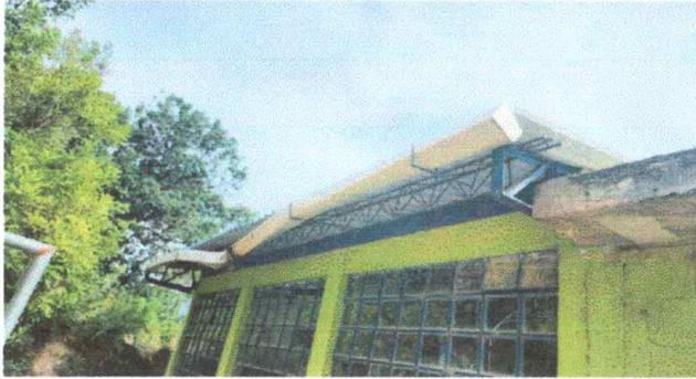
Foto 7: MÓDULO 2: Sustitución de canal de metal
