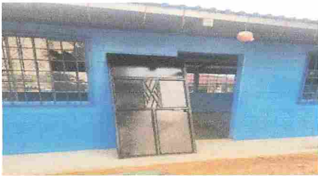
Foto 3: SUSTITUCIÓN DE PUERTA
