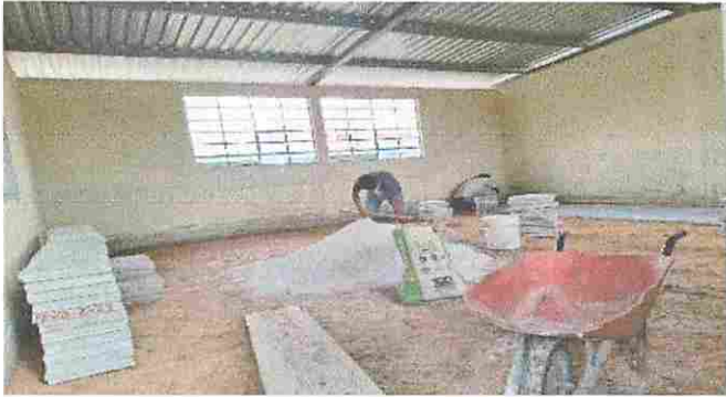
Modulo 1: SUSTITUCIÓN DE PISO CERÁMICO POR PISO DE GRANITO
