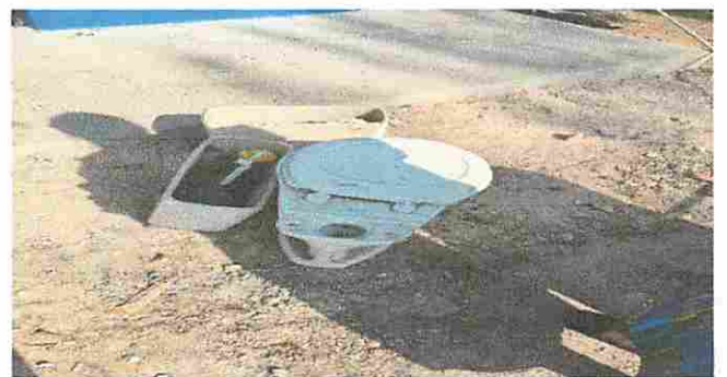
Foto 6: SUSTITUCIÓN DE INODOROS
