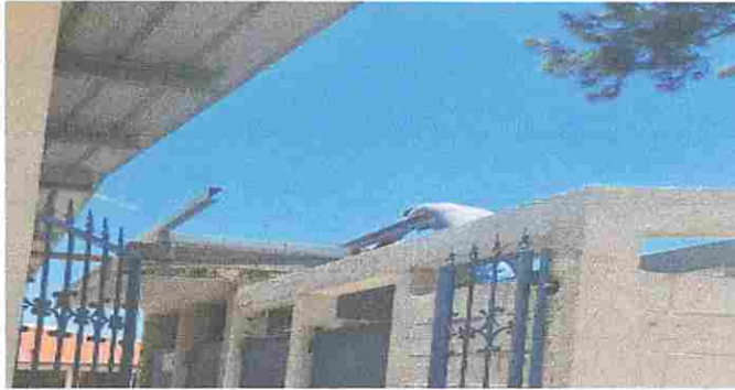
Modulo 7: SUSTITUCIÓN DE DEPÓSITO DE AGUA
