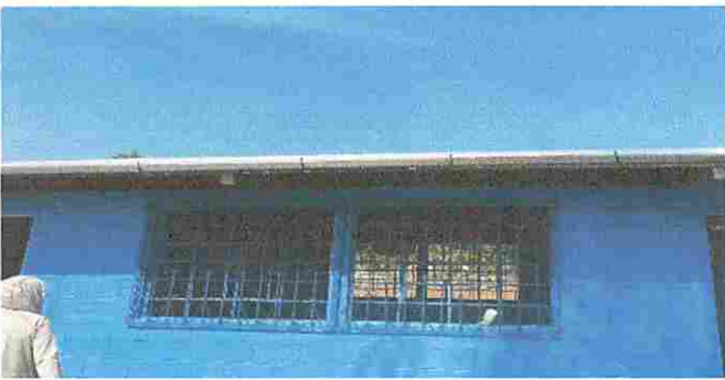
Foto 5: SUSTITUCIÓN DE CANAL
