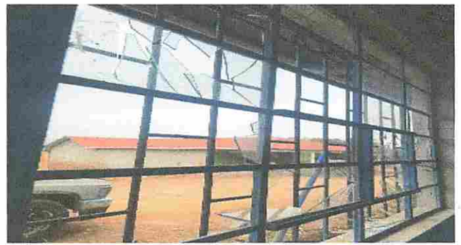
Foto 4: SUSTITUCIÓN DE VIDRIOS
