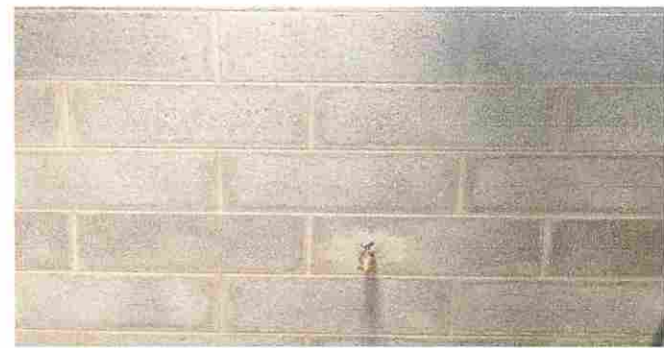
Foto 9: SUSTITUCIÓN DE LLAVE DE CHORRO
