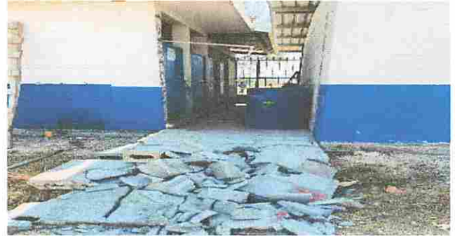
Modulo 8: SUSTITUCIÓN DE MURO DE BLOCK
