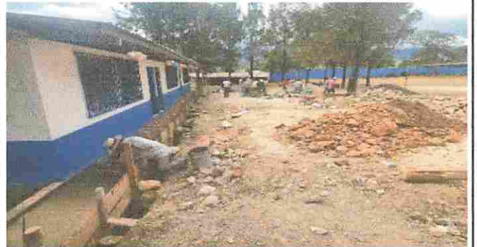
Modulo 2: REPARACIÓN DE BANQUETA DE CONCRETO
