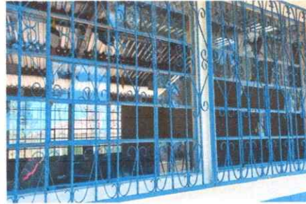
Foto 2: Sustitución de Vidrios de tres aulas.
