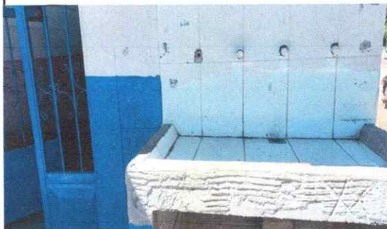
Foto 5: Sustitución de lavamanos.
