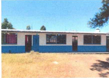
Foto1: Sustitución de canales pluviales.
