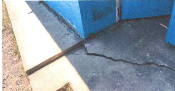
Foto 4: Sustitución de aceras
