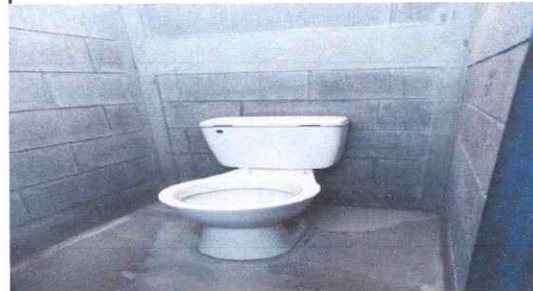
Foto 6: sustitución de inodoros
