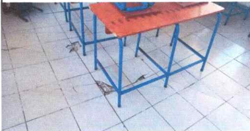
Foto 3: Sustitución de piso de tres aulas.
