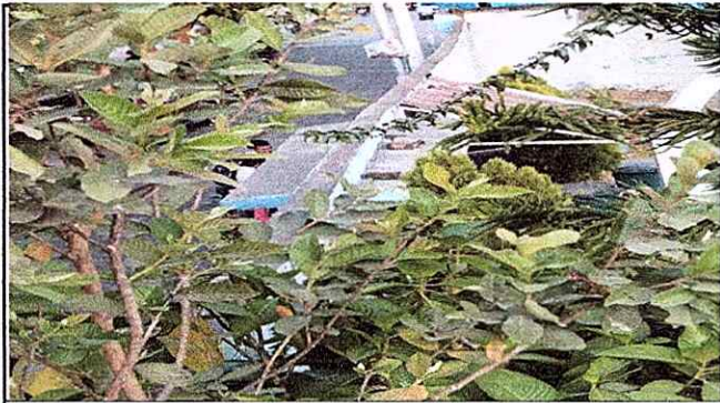
Foto1: Pared de muro perimetral desplomada, vista aerea.
