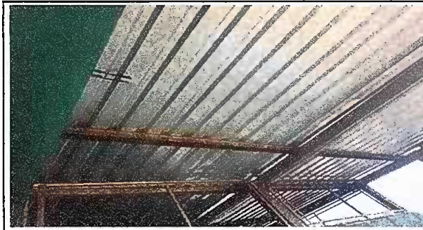
Foto 3: Sustitución de lamina, por lamina troquelada aluzinc calibre 26
