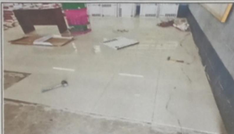
Foto 1: Sustrucion de piso de torta de concreto por piso cerámico
