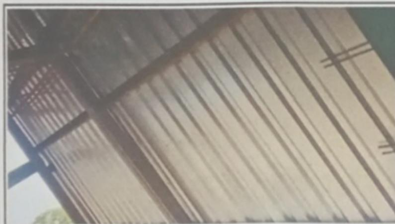
Foto 3: Sustrucion de lamina, por lamina troquelada aluzinc calibre 26
