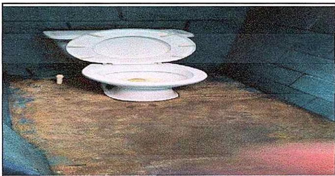
Foto 6: Sustrucion de accesorios inodoro (contra llave, tubo de abasto y tanque)
