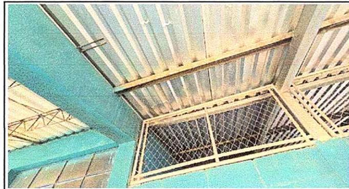
Foto 3: Sustrucion de lamina, por lamina troquelada aluzinc calibre 26
