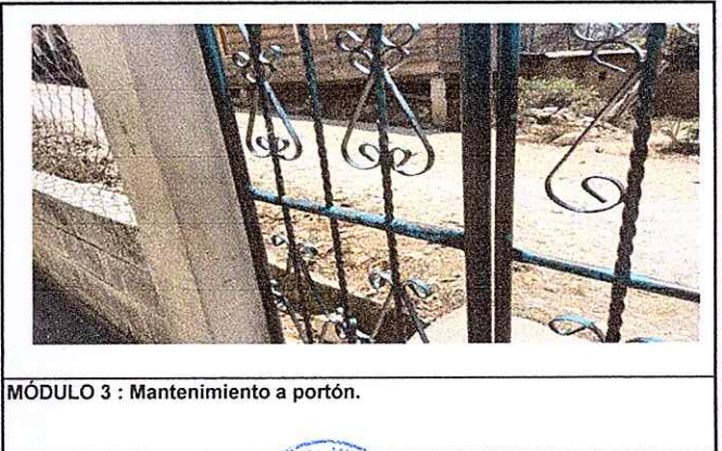
MÓDULO 3 : Mantenimiento a portón.
