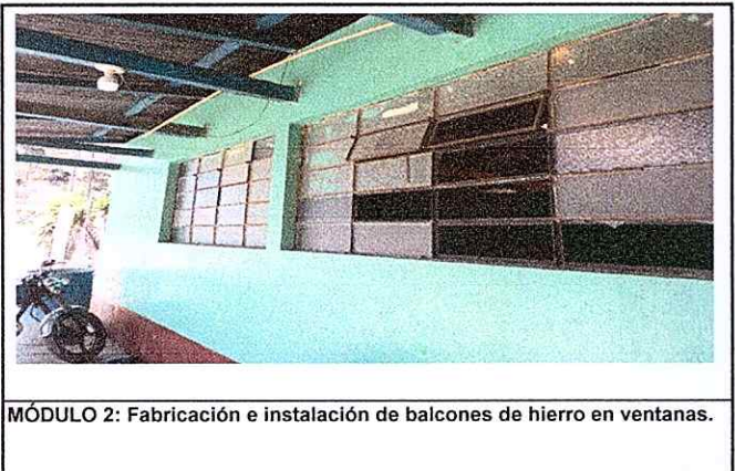
MÓDULO 2: Fabricación e instalación de balcones de hierro en ventanas.
