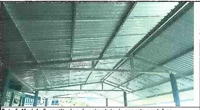
Foto 5: Modulo 2. sustitución de estructura de soporte por tubos galvanizados
