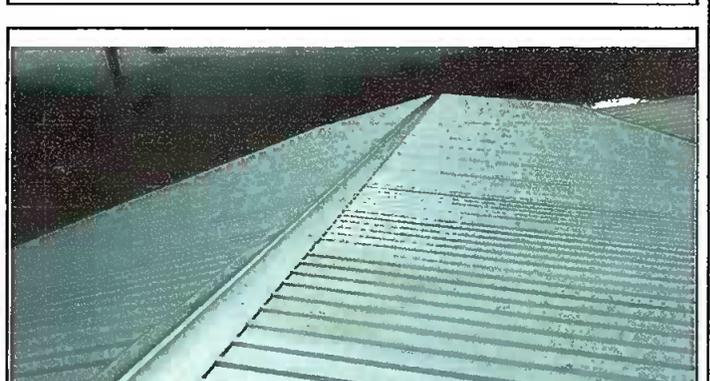
Foto 4: MODULO 2. Sustitución de lamina por lamina troquelada aluzinc calibre 26
