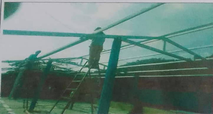
Foto 3: MODULO 2. sustitución de capotes por capotes troqueladas aluzinc calibre 26
