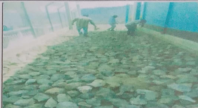
Foto 2: MODULO 1 .sustitución de gradas
