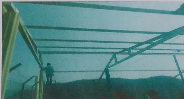
Foto 6: MODULO 2. Suministro en Instalación de canal de metal
