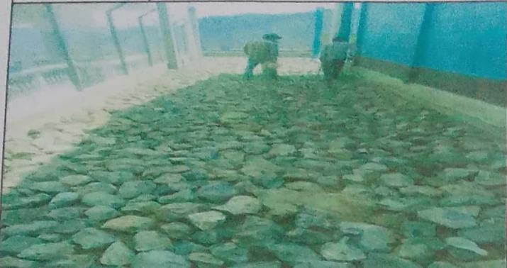
Foto 1: MODULO 1. Sustitución de piso de torta de concreto
