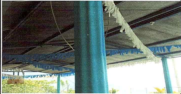
Foto 7: MODULO 2. Columnas de concreto
