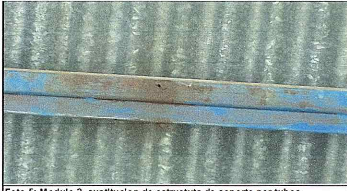
Foto 5: Modulo 2. sustitucion de estructura de soporte por tubos galvanizados
