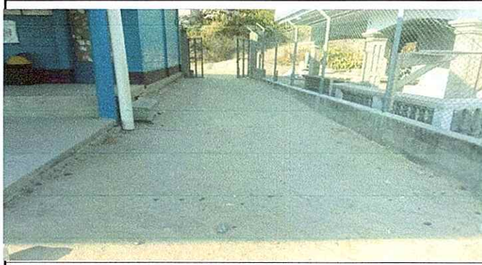
Foto 1: MODULO 1. Sustitución de piso de torta de concreto
