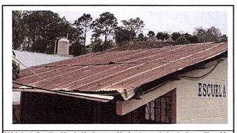
Módulo 1: Sustitución de lámina, por lámina troquelada aluzinc calibre 26
