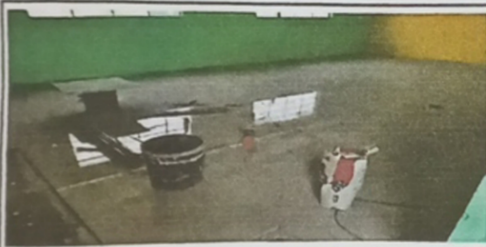
Modulo 1. Sustitución de piso de torta de concreto por piso cerámico.
