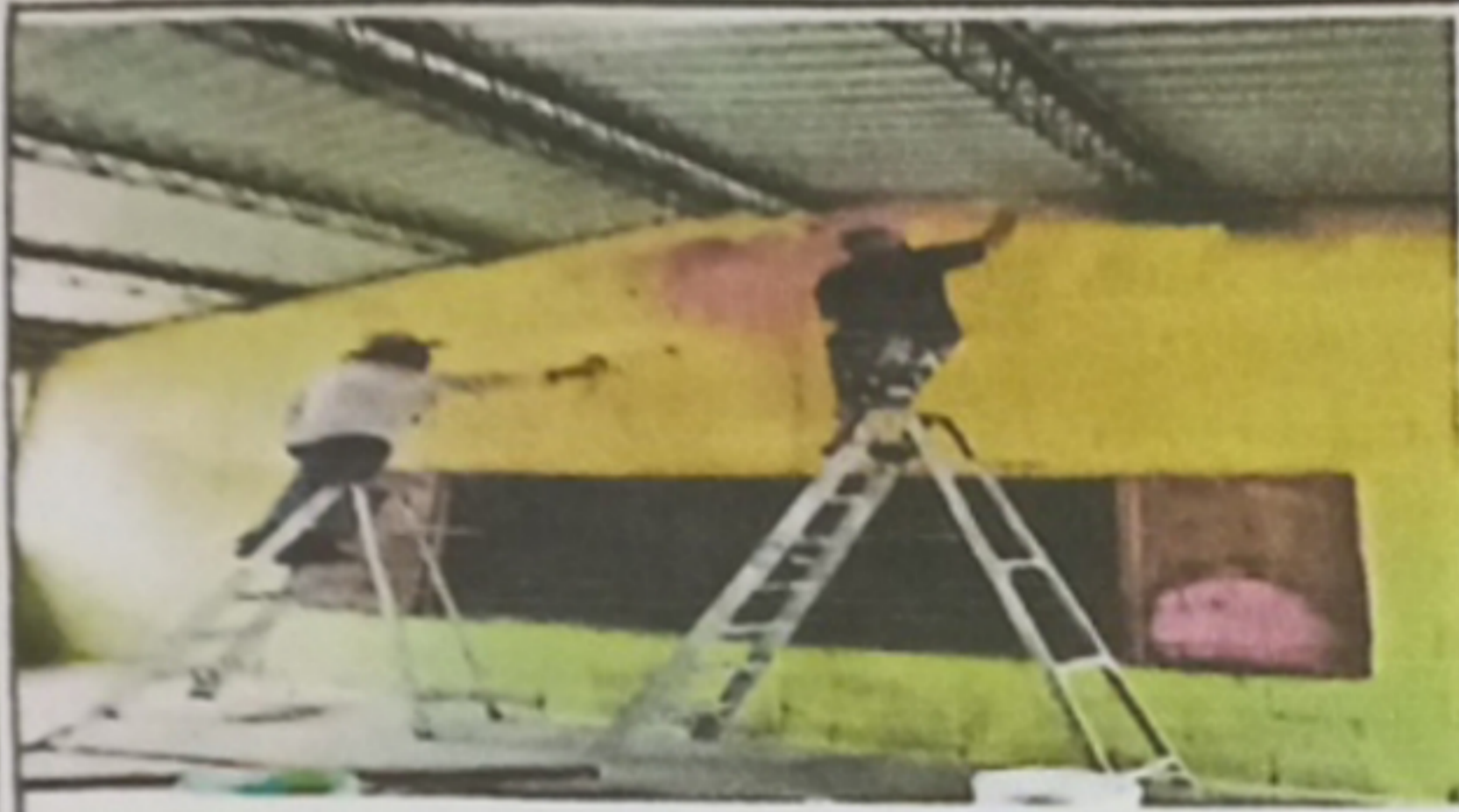
Modulo 1. Sustitución de piso de torta de concreto por piso cerámico. Pintura en muros exteriores e interiores
