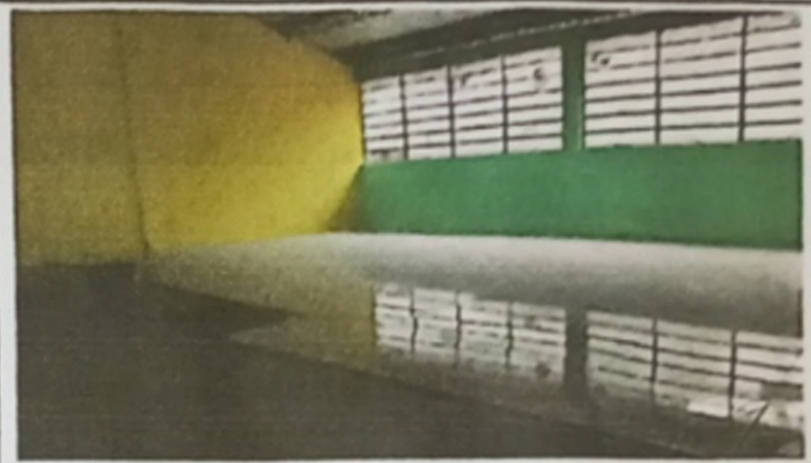
Modulo 1. Sustitución de piso de torta de concreto por piso cerámico. Pintura en muros exteriores e interiores.
