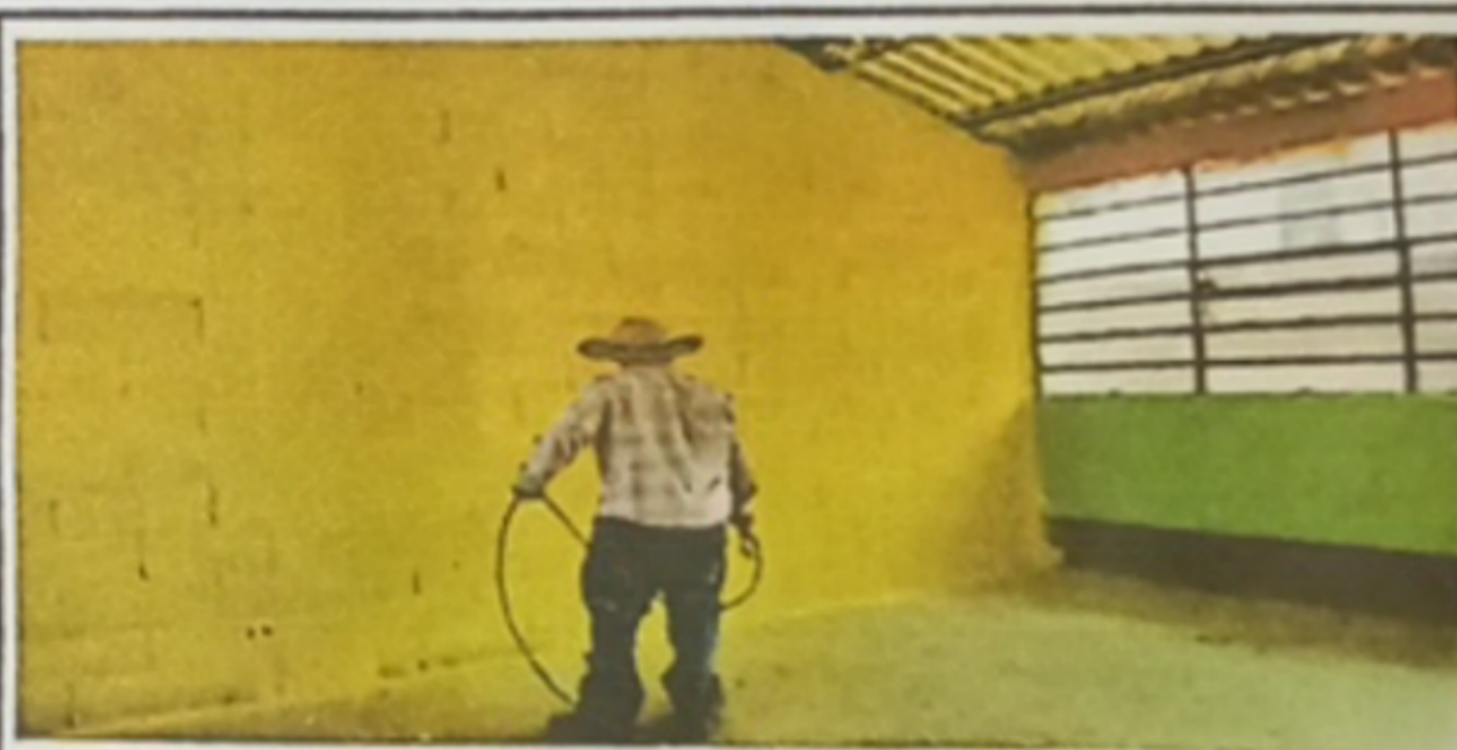
Modulo 1. Sustitución de piso de torta de concreto por piso cerámico.
