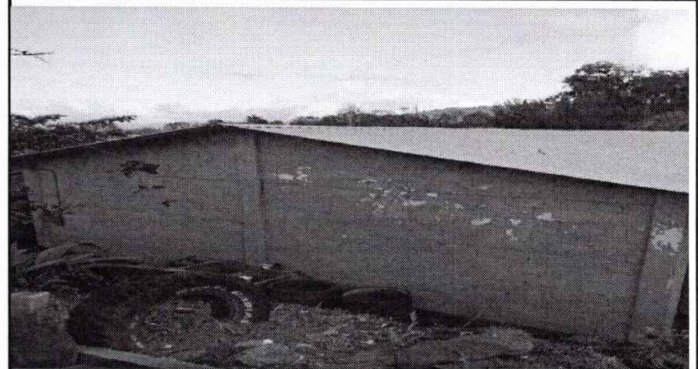
Modulo 1. Sustitución de piso de torta de concreto por piso cerámico. Pintura en muros exteriores e interiores.
