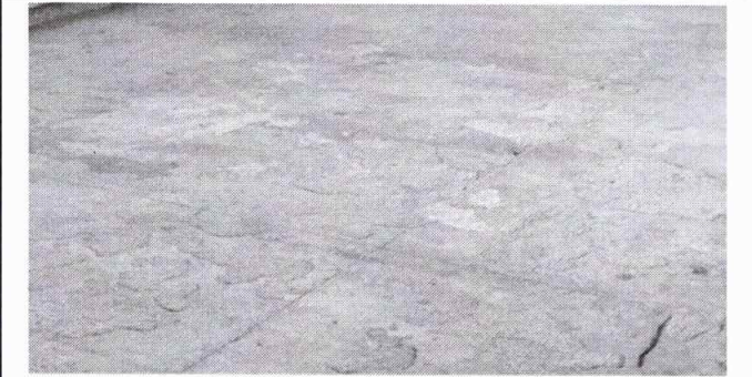
Modulo 2. Sustitución de piso de torta de concreto por piso cerámico.
