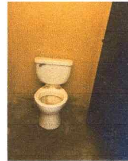
Foto 4: Reparación de accesorios de inodoro.
