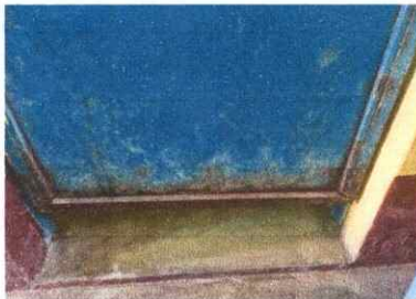
Foto 5: Sustitución de puertas de baños.
