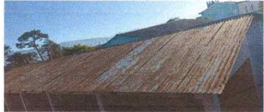
Foto 2: Sustitución de techos de aulas.
