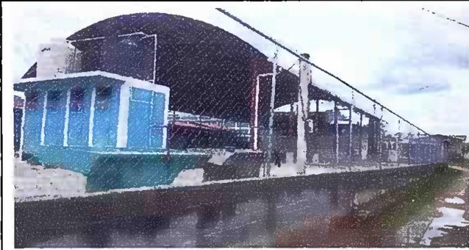
Foto 1: FINALIZADO REPARACIÓN DE MURO PERIMETRAL DE BLOCK CON TUBO HG Y MALLA GALVANIZADA, SOLERAS INTERMEDIAS Y COLUMNAS
