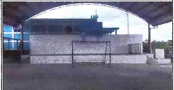
Foto 2: FINALIZADO REPARACIÓN DE MURO PERIMETRAL DE BLOCK, SOLERAS INTERMEDIAS Y COLUMNAS
