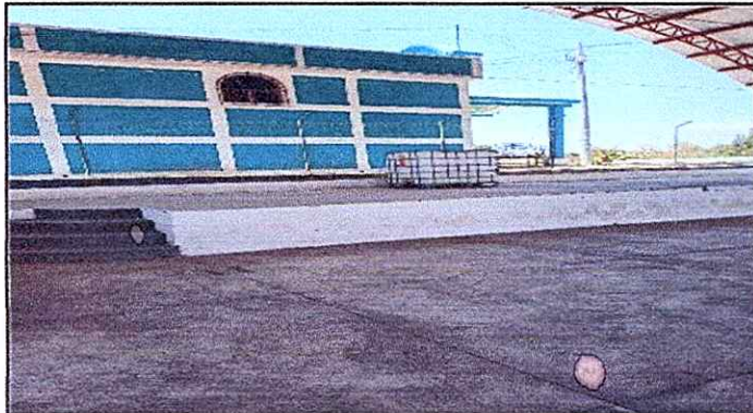
Foto 3: REPARACIÓN DE MURO PERIMETRAL DE BLOCK
