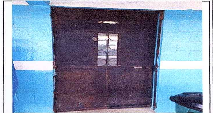
Foto 4: SUSTITUCIÓN DE PUERTA DE METAL
