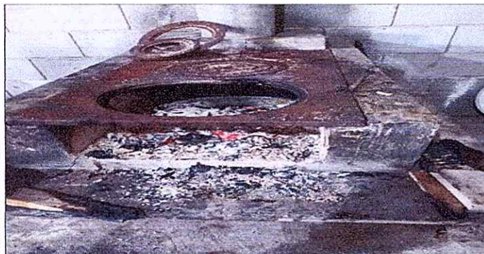
Foto 5: SUSTITUCIÓN DE PLANCHA DE METAL Y REPARACIÓN DE POLLO
