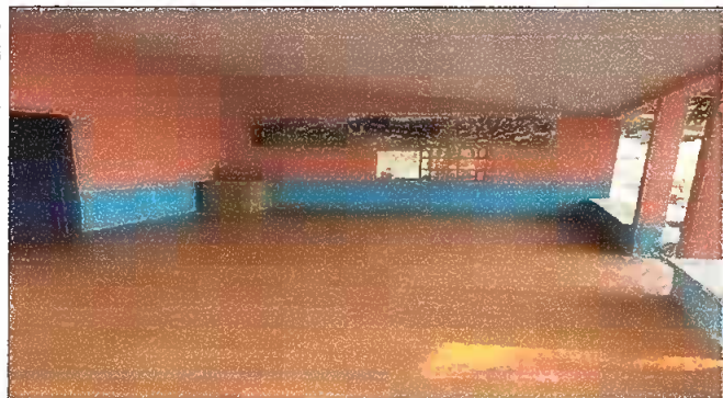
Módulo 1: Sustitución de piso cerámico
