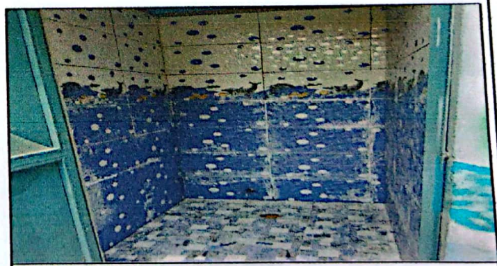
Módulo 2: Sustitución de azulejo
