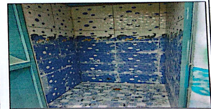
Módulo 2: Sustitución de azulejo
