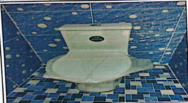
Módulo 2: Sustitución de inodoro
