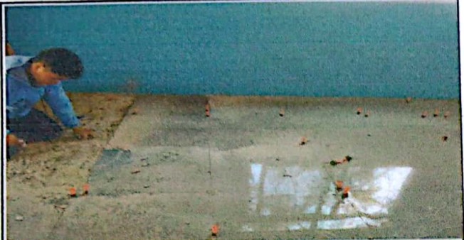
Módulo 1: Sustitución de piso porcelanato
