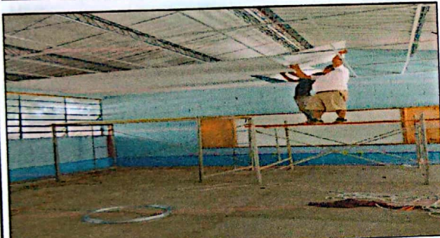
Módulo 3: Sustitución de cielo falso
