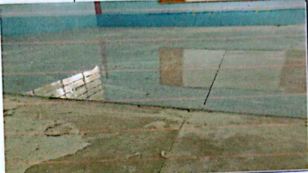
Módulo 3: Sustitución de piso porcelanato
