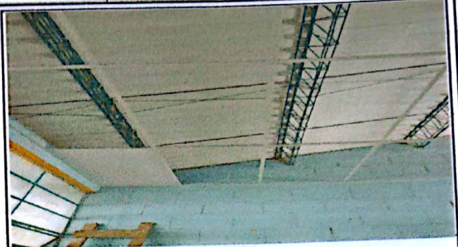
Módulo 1: Sustitución de cielo falso
