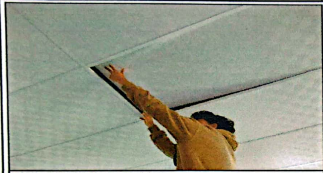
Módulo 4: Sustitución de cielo falso
