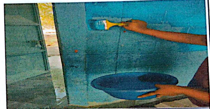
Módulo 1: Pintura de paredes interiores y exteriores
