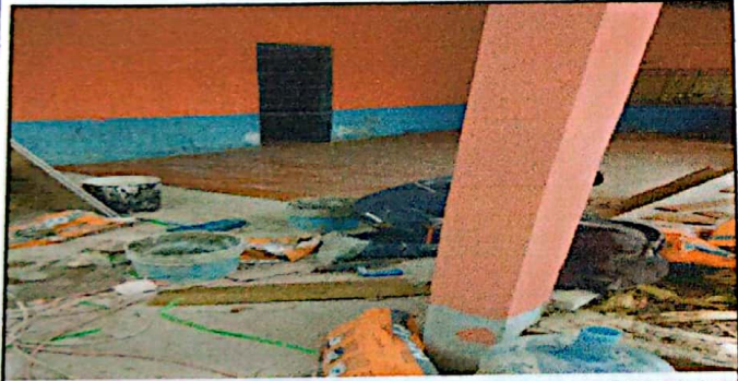
Módulo 1: Sustitución de piso cerámico
