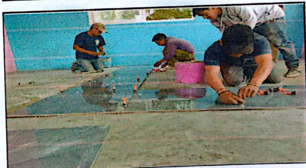
Módulo 4: Sustitución de piso porcelanato
