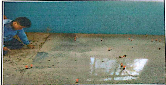
Módulo 1: Sustitución de piso porcelanato
