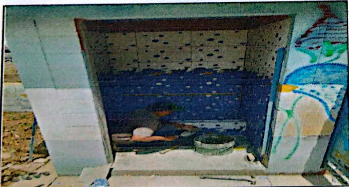
Módulo 2: Sustitución de piso cerámico
