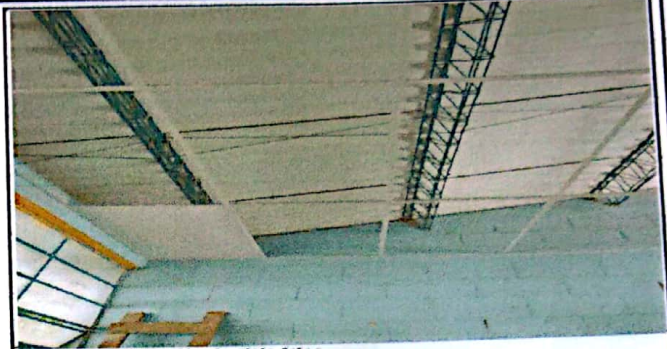
Módulo 1: Sustitución de cielo falso
