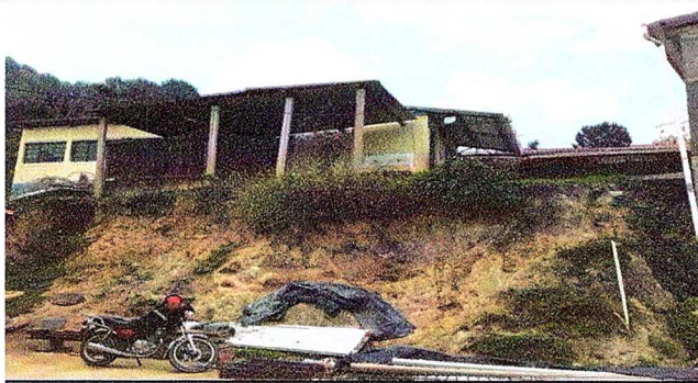
FOTO: 3 VISTA FRONTAL DE ESPACIO DONDE SE PLANTEA REPARAR MURO DE CONTENCIÓN.
