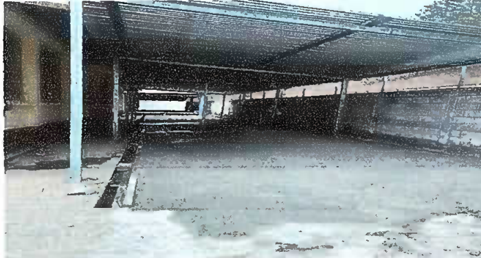
Foto 1: Reparación de piso de torta de concreto.
