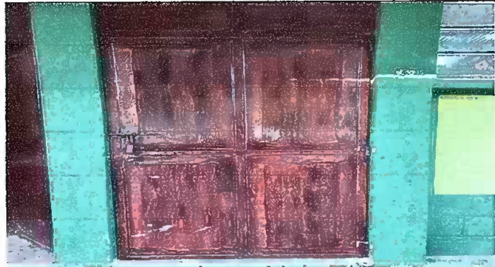
Foto 3: Sustitución de puerta (1x2.93mts)
