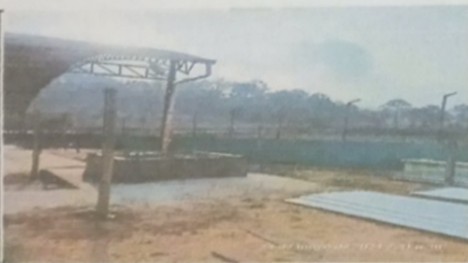
Foto 5: Sustitución de lámina, por lámina troquelada aluzinc calibre 26 y Sustitución de estructura de soporte de madera, por metal.
