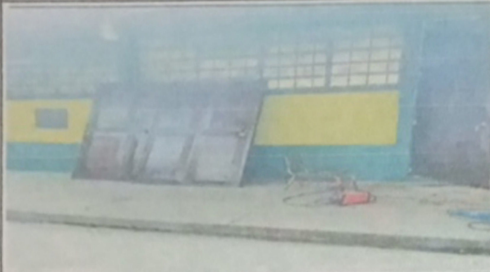
Foto 1: Sustitución de puerta (1x2.93mts)
