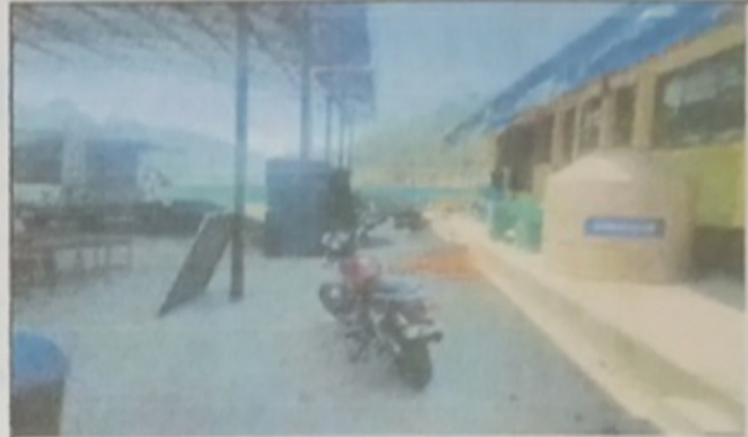
Foto 2: Sustitución de depósito de agua 1100 lt y Sustitución lavamanos.
