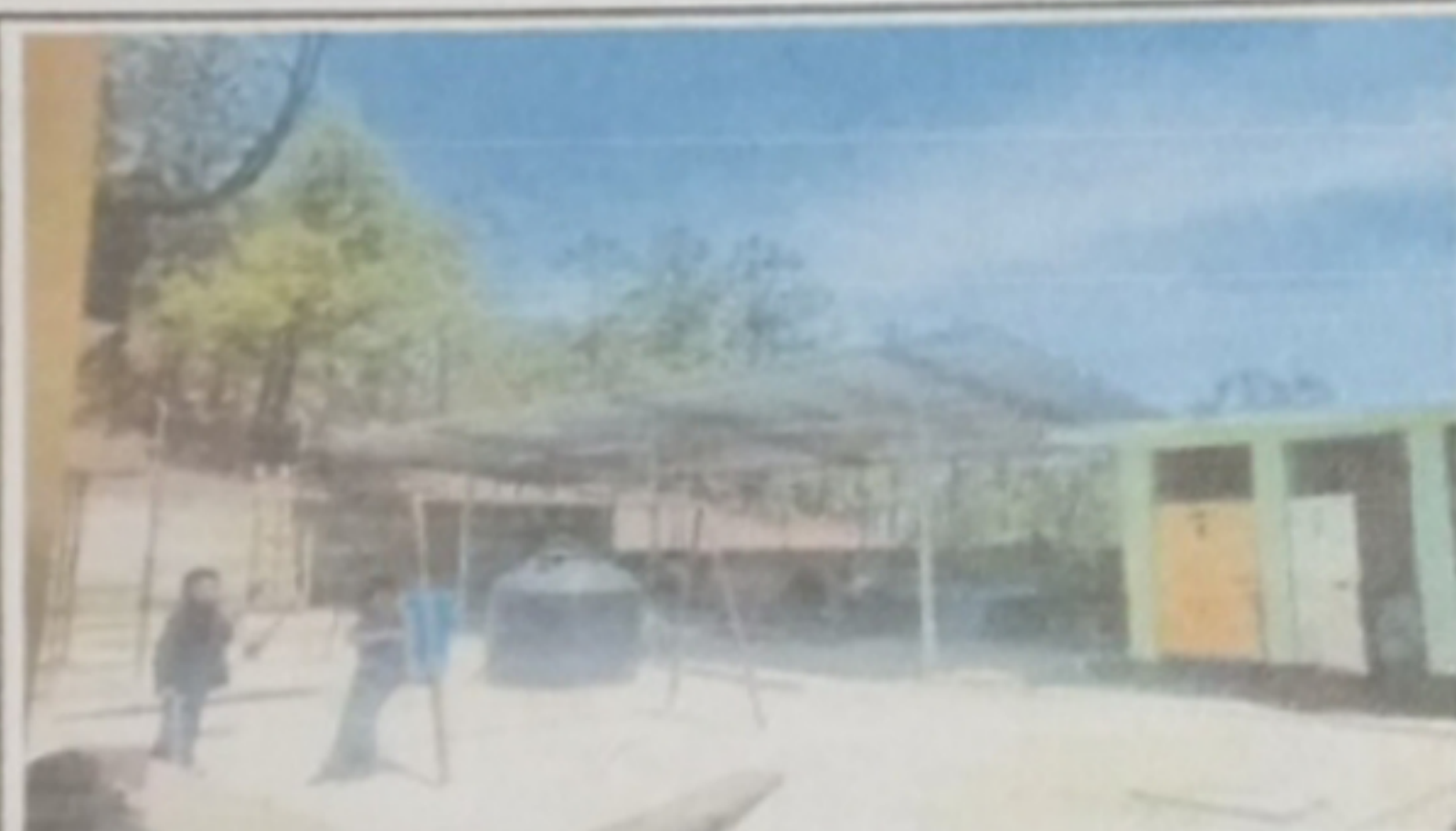
Foto 3: Colocación de lámina sobre pilas
