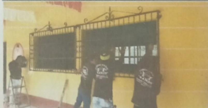
Modulo 3 Foto 6: Sustitución de estructura de metal, vidrio de ventana y balcones de metal
