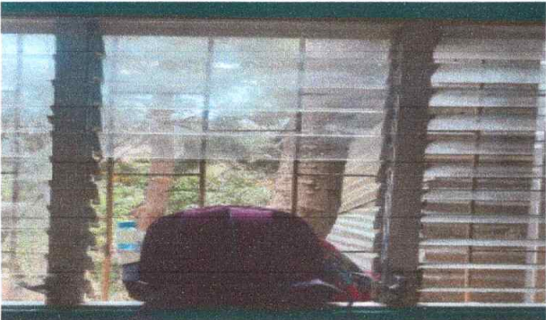
Modulo 3 Foto 9: Sustitución de estructura de metal, vidrio de ventana y balcones de metal
