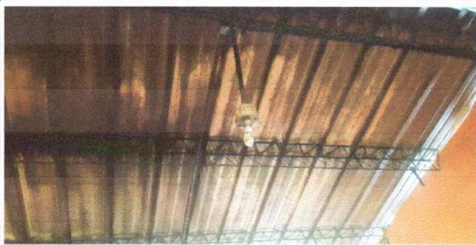
Modulo 1 Foto 3: Sustitución de lamparas tipo LED en la cocina
