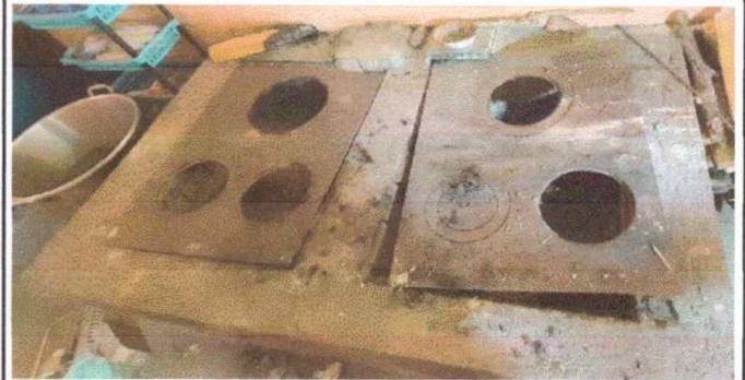
Modulo 1 Foto 2: Sustitución de estufa rural (completa) incluye chimenea y plancha de metal
