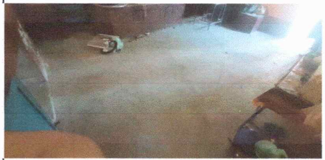
Modulo 1 Foto 4: Sustitución de piso cerámico
