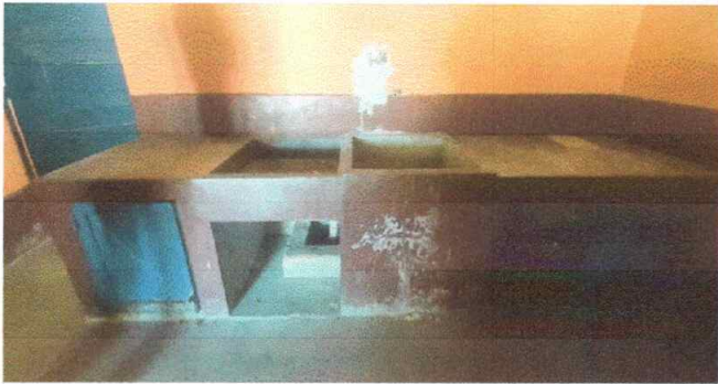
Modulo 1 Foto1: Remodelacion de pila, en la cocina.
