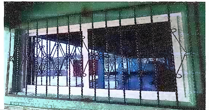
MODULO 4 Sustitución de ventanas
