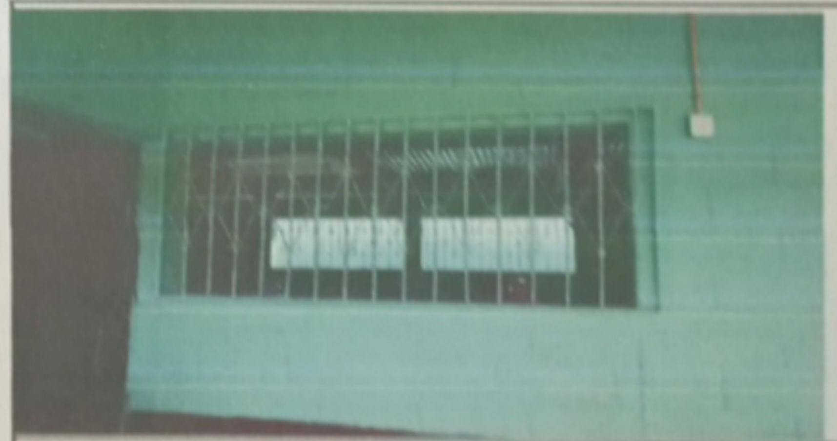
MODULO 4 Sustitución de ventanas
