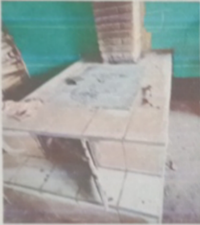
Foto 2: Sustitución de estufa rural (completa) incluye chimenea y plancha de metal
