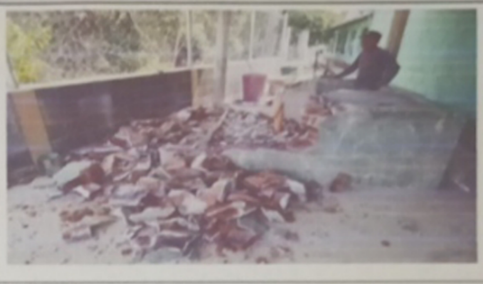
MODULO 5 Sustitución de pila de cemento de dos lavaderos
