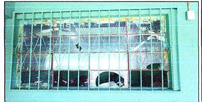
MODULO 4 Sustitución de ventanas
