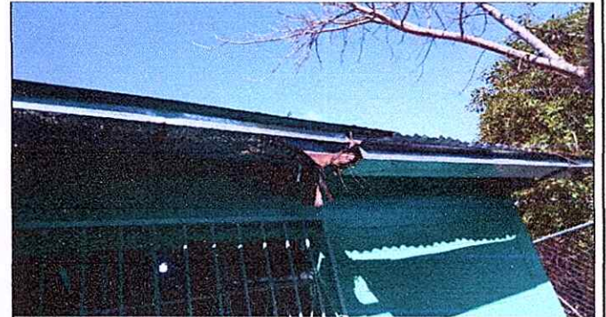
MODULO 3 sustitución de canal de metal
