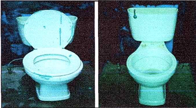
MODULO 1 Sustitución de inodoros
