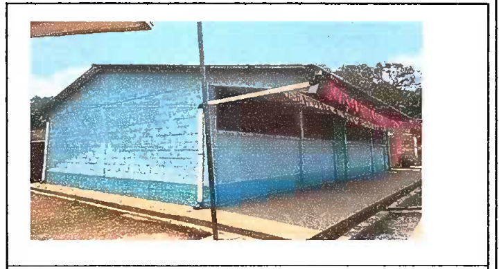
Modulo 2. Suministro e instalacion de canal de metal e instalacion de bajada de agua pluvial
