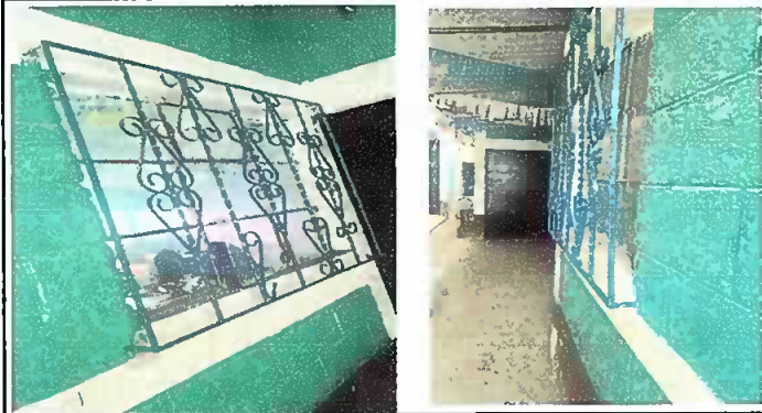
Foto13: Mantenimiento de balcones completado
