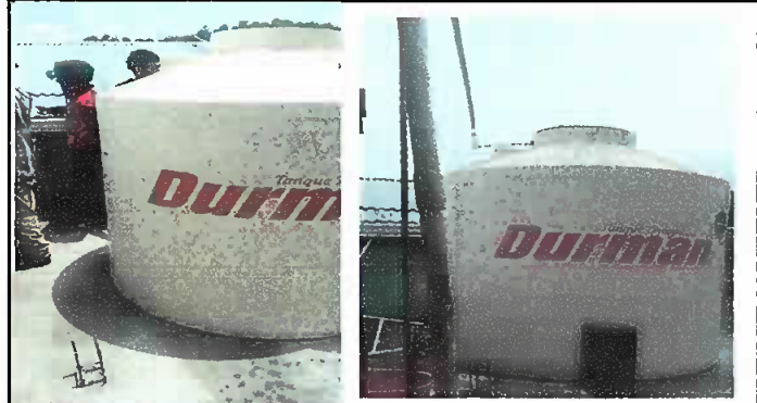
Foto 2: Tinaco nuevo e instalado.
