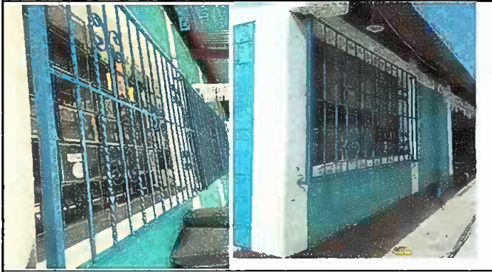
Foto 3: Balcones para aulas y bodegas instaladas.
