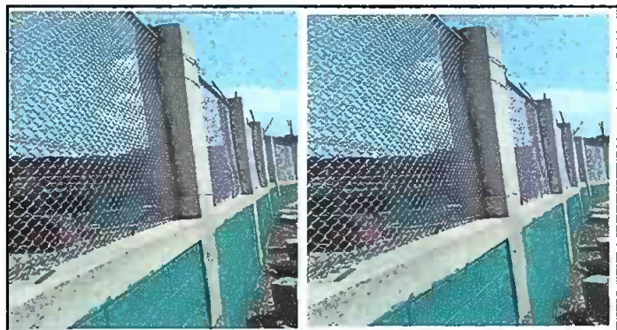
Foto 6: Malla de circulación nuevo, colocado e instalado
