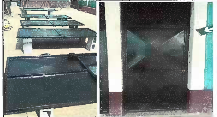
Foto 14: Mantenimiento de puertas completado
