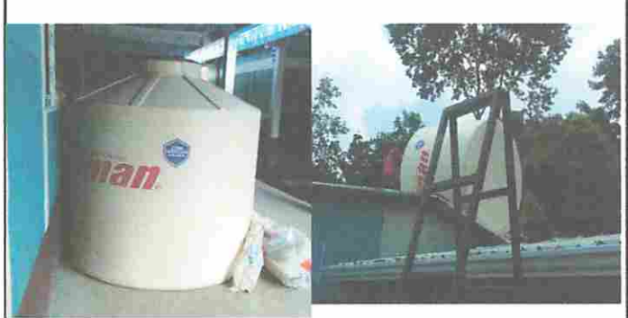
Foto 2: Proceso de Sustitución del Tinaco por uno nuevo
