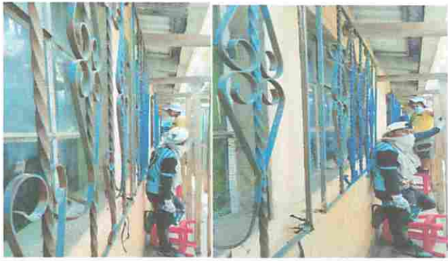
Foto13: Proceso en Mantenimiento de balcones
