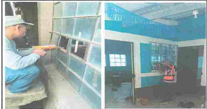
Foto 4: Proceso de colocación de vidrios
