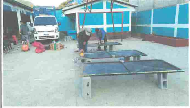
Foto 14: Proceso en Mantenimiento de puertas
