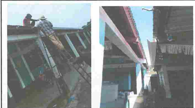
Foto 16: Proceso en colocación de canal de agua
