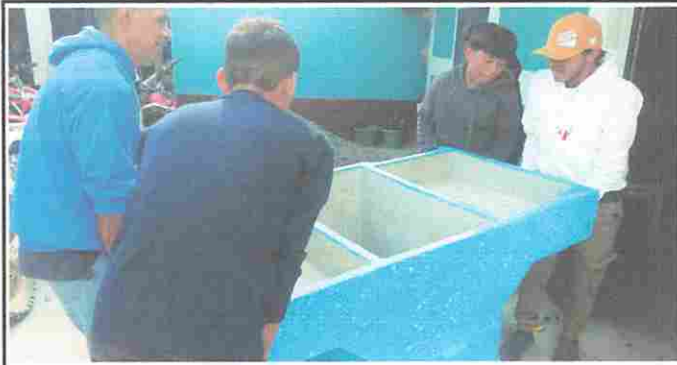
Foto 15: Proceso de Sustitución de pila de dos lavadero
