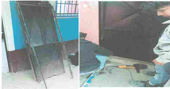
Foto1: Procesos de Sustitución de puertas de metal de los 3 sanitarios
