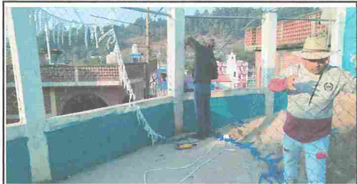
Foto 6: Proceso de Sustitución de malla de circulación por nuevo
