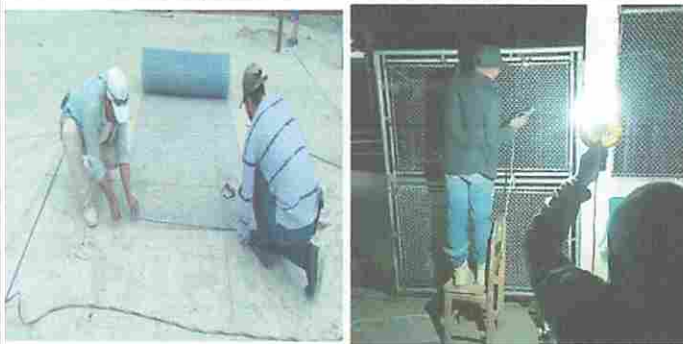
Foto 5: Proceso de Cambio de malla del porton de ingreso por deterioro
