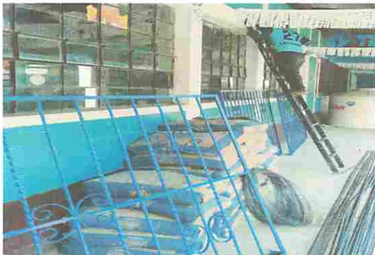
Foto 3: Proceso de colocación de balcones para aulas y bodegas
