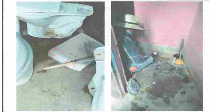
Foto7: Proceso de Sustitución de las tazas de inodoros de los 3 sanitarios
