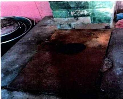
Foto 11: sustitución de plancha de cocina por uno nuevo
