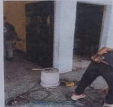
Foto 4: INSTALACION DE PUERTAS METALICAS
