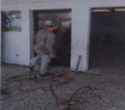
Foto 3: INSTALACION DE PUERTAS METALICAS
