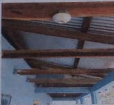
Foto 5: INSTALACION ELECTRICA, ILUMINACION.
