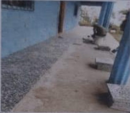
Foto 1: INSTALACION DE PISO DE GRANITO EN CORREDOR
