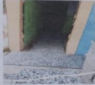
Foto 2: INSTALACION PISO GRANITO EN AULA Y CORREDOR
