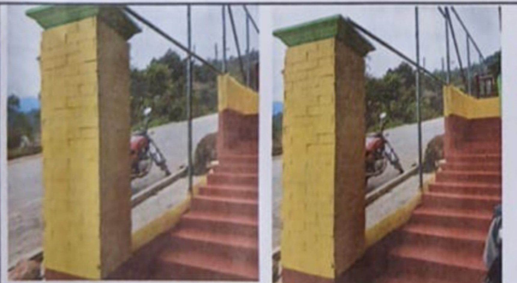
Foto 5: sustitucion malla y tubo
