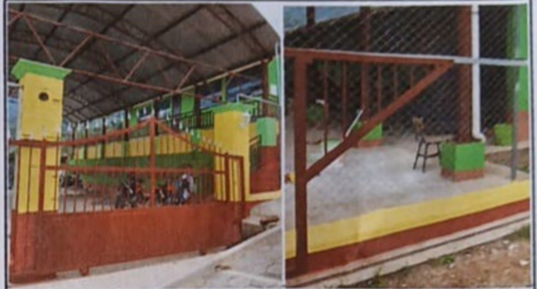
Foto 2: guia rodo y pintura de porton
