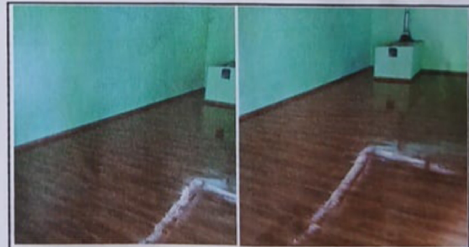
Foto 6: sustitucion de piso a ceramica
